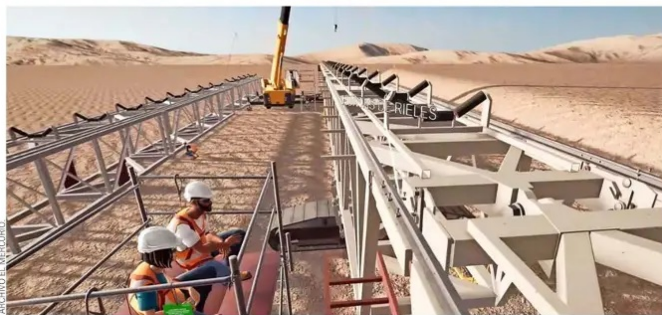
En el metaverso, los proveedores podrán conocer "in situ" las condiciones que se deben enfrentar en una faena para desarrollar soluciones a la medida.
