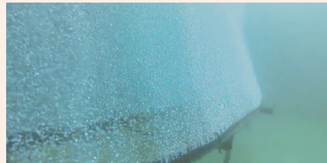
Detalle doble cortina de microburbujas en torre de captación de agua.
