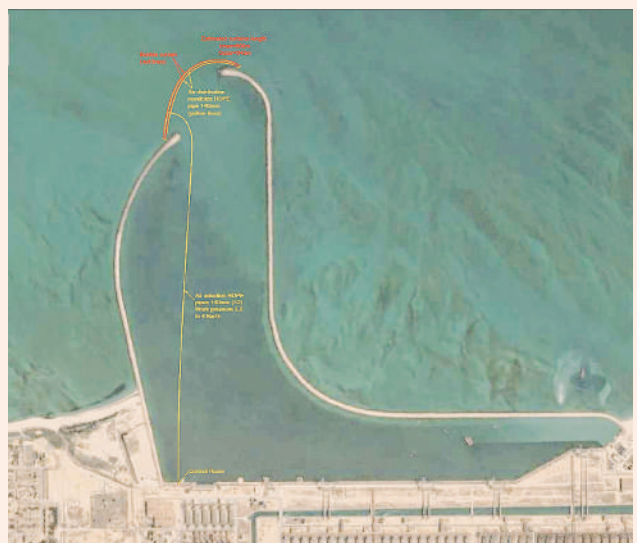
Zona de acción de la cortina de microburbuja en planta desaladora en Al Jubail, Arabia Saudita.
